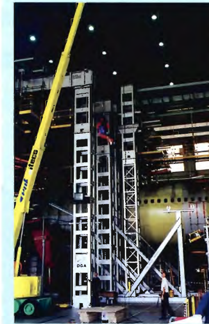
Descente en cours
